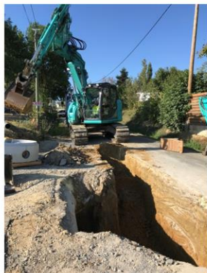
Zone de chantier
