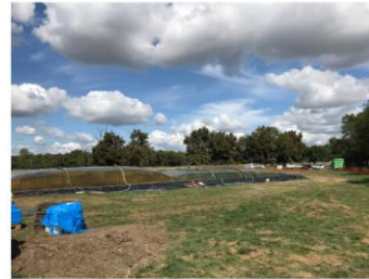
Géotubes avec boues
