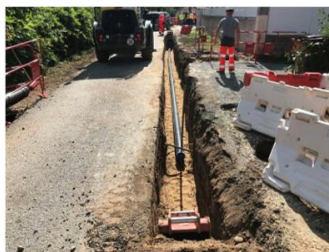
Conduite – Route de la Fosse du Moulin
