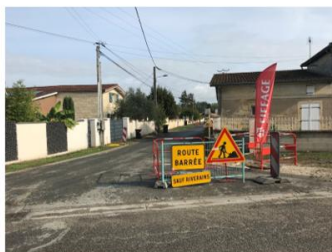
Signalisation – Rue de la Grave
